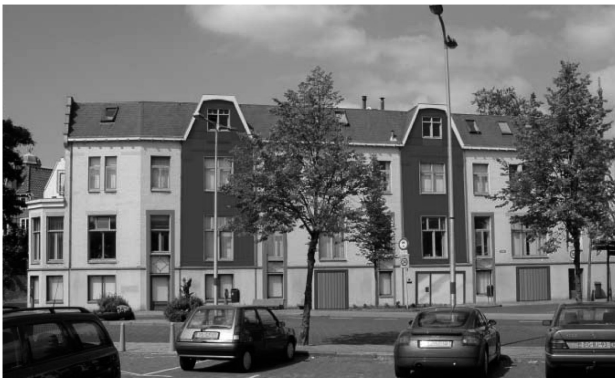
Stadsvilla's aan de Zandpoort
