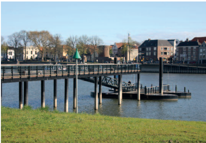
De aanlegsteiger op de Worp
