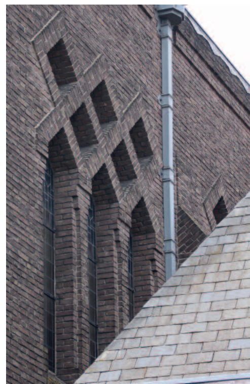
Venster met siermetselwerk van baksteen
