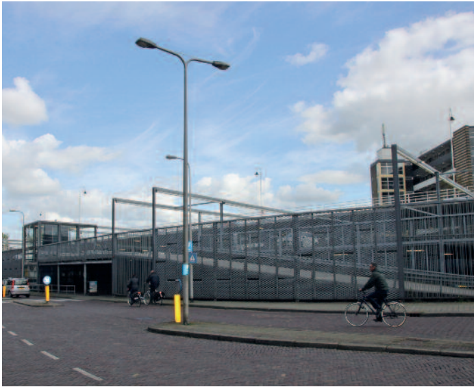
De oprit van de Wilhelminabrug als scheidsmuur
