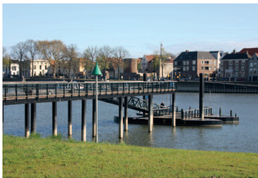
De aanlegsteiger op de Worp
