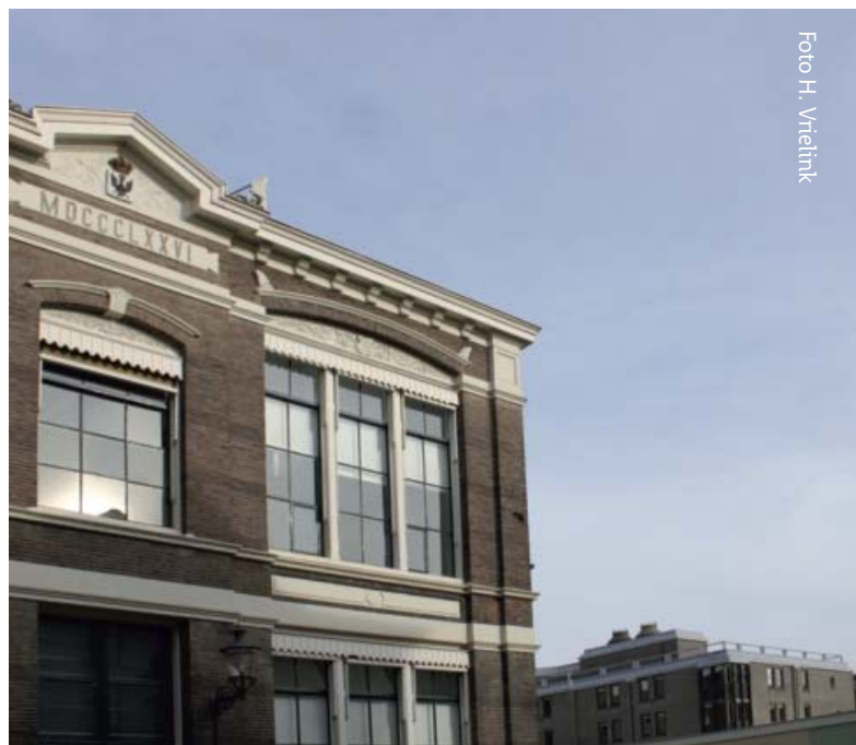
Twee karakteristieke gebouwen worden afgebroken
