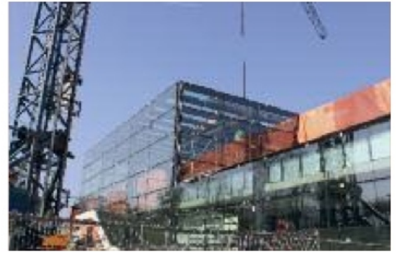
Perron 3 in aanbouw
