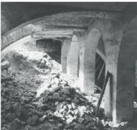
De vijftiende-eeuwse kelder van huis De Schuur tijdens de sloop van de schouwburg in 1953 (collectie SAB Deventer)
