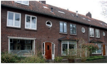
Een rijtje van vier huizen (nr. 29-35) van Jac. Haket uit 1949; de panden uit de wederopbouwperiode sluiten wel aan bij het basismodel, maar zijn er toch duidelijk van te onderscheiden
