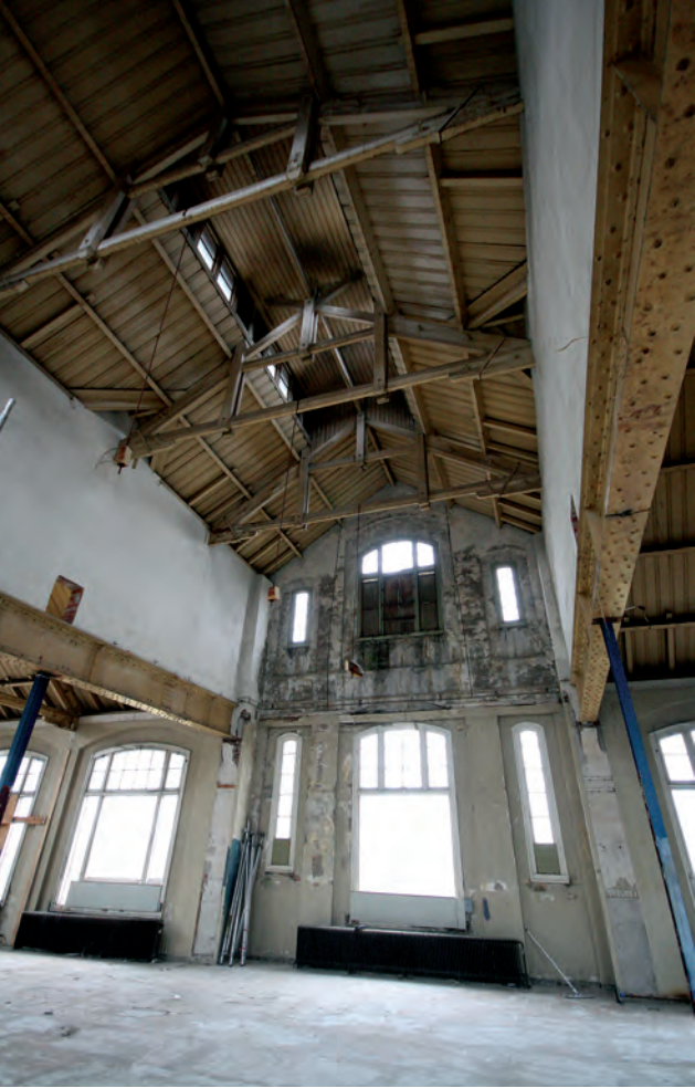
Kapconstructie met luchtkap in het Apparatengebouw (foto Architecten_Lab)
