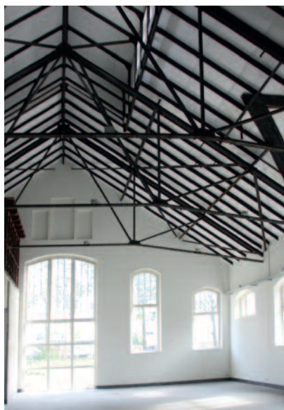
Boven. De nieuwe aanbouw tegen het Meterhuis Onder. Stalen spanten in het Ketelhuis
