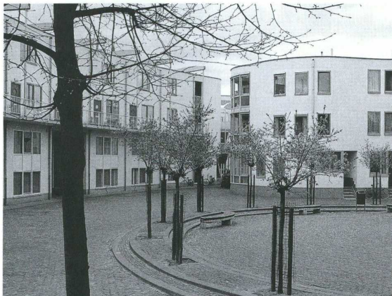
Sijzenbaan, ontwerp Theo Bosch uit 1987. Een nieuwbouwcomplex van hoge architectonische en stedenbouwkundige kwaliteit.
