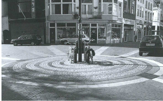
Merkwaardig bestratingspatroon: cirkelvormige blindenstrook rondom een lantaarnpaal, afvalbak en antiparkeerpalen.
