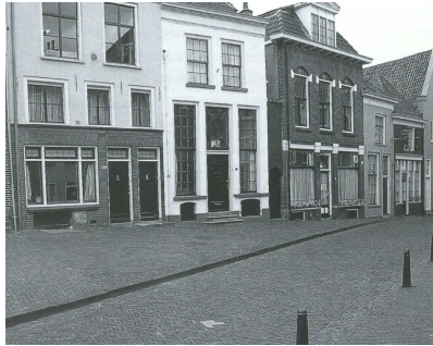
Algemene beeldkenmerken: continue voorgevelrooilijnen van bebouwing, driedelige gevelopbouw, kappen, staande gevelopeningen en verscheidenheid en verfijning in detaillering en profilering.
