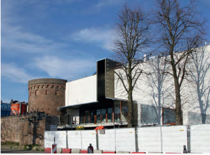
De gevel van theater Mimik lager dan de vestingstoren
