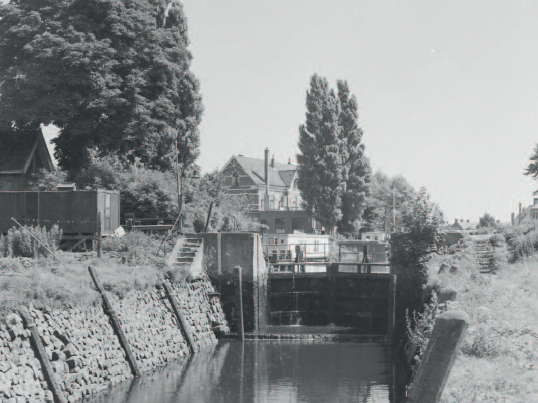
Foto boven. Verwijderen van de basaltblokken. De schotbalken zitten in de sponning van het sluishoofd. Ook is het aantal treden in de trap goed te zien. (1960/70, Beeldbank Deventer; foto D.W. Nijland)
