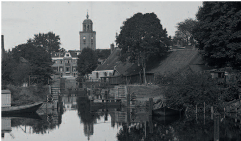
Sluis met trappen en aansluitend dijkje (1900/30, Beeldbank Deventer; foto J.W. Jansen)
