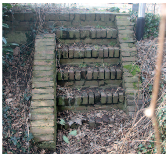
Het nog aanwezige sluishoofd met deels begraven trap
