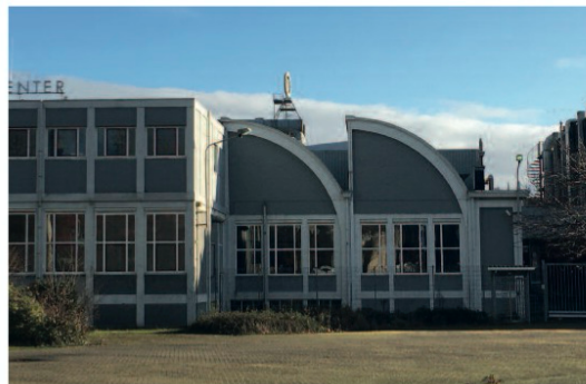
Het gedeelte van Roto Smeets dat behouden blijft
