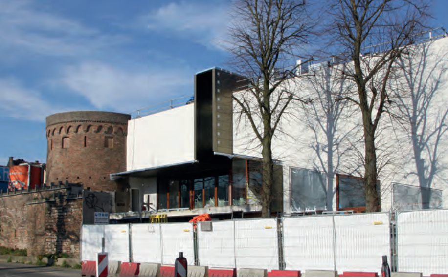
De planadviesraad adviseerde de gevel van Mimik te verhogen om de installaties op het dak aan het zicht te onttrekken. Op aandringen van de SOD bleef de gevel lager dan de muurtoren
