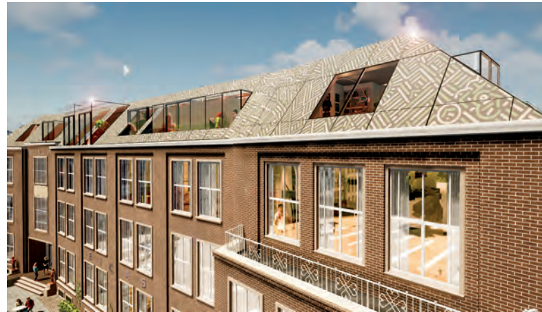
Het nieuwe dak van het schoolgebouw aan de Nieuwe Markt met kunstwerk van glas en de grote glazen lantaarns (1618 Vastgoed BV) Ontwerp Hans van Heeswijk
