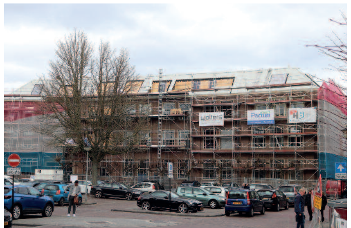
Gymnasium/MMS met nieuw dak
