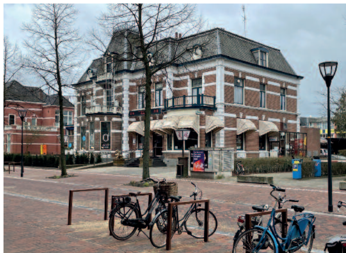
Keizerstraat 41 met toegevoegde entree en serre (foto SteenhuisMeurs)
