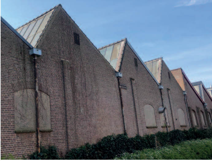
Het ritme van de sheddaken
