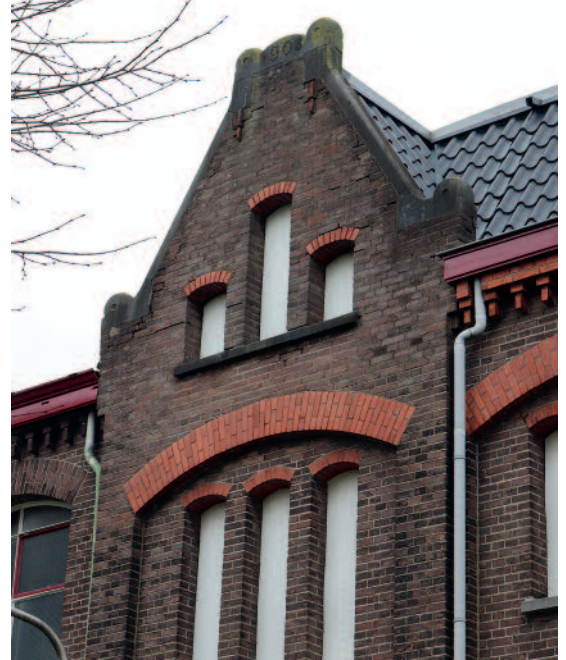
Detail van het fraaie metselwerk
