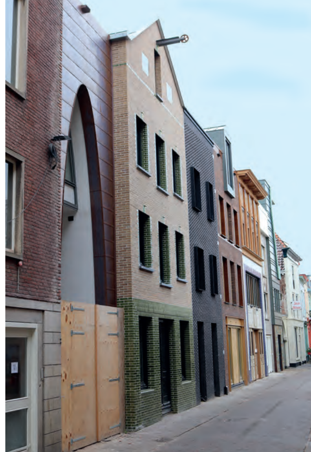
De gevelwand in de Kleine Overstraat in 2023
