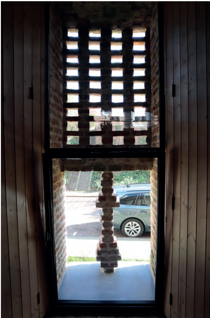
Het raam met het open metselwerk
