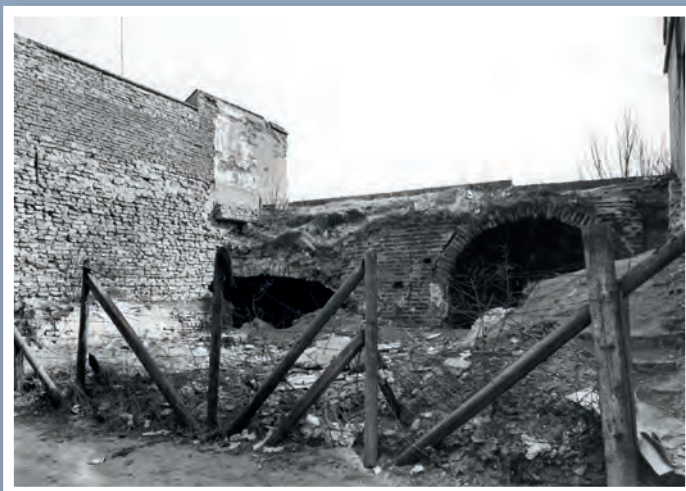
Het Rondeel in de stadsmuur aan de kant van Achter de Muren Zandpoort voor de restauratie in 1970 (HCO)
