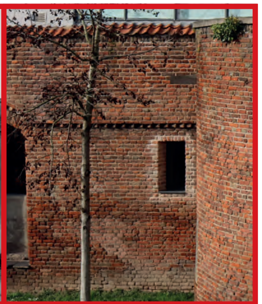
De herstelde schildmuur met daarboven de borstwering die op een muizentand is overgebouwd
