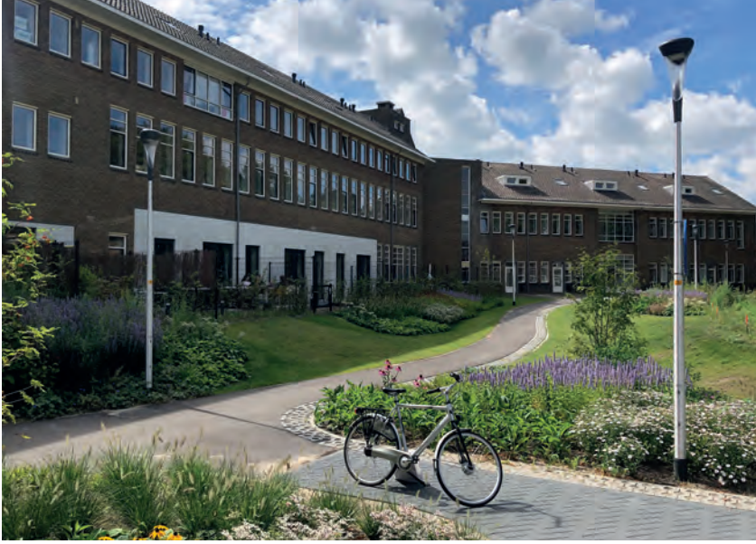
Links. Gevel aan zijde van de van Calcarstraat met terrassen Onder. Reconstructie van het carré gezien vanaf Ceintuurbaan
