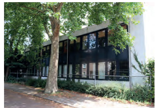
De kantoorvleugel aan de Burgemeester van Heemstralaan
