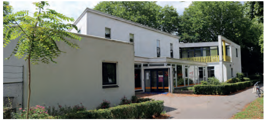
Alleen het lage gebouwdeel vooraan oogt nog origineel.
