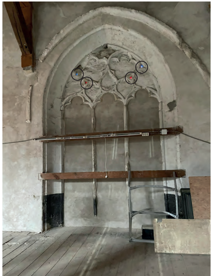
Traceringen in de vensters met enkele minieme stukjes glas-in-lood (omcirkeld)
