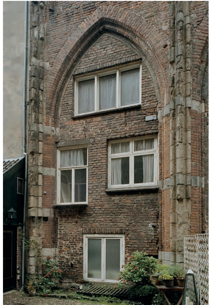
Achtergevel van de huizen aan de Nieuwe Markt (foto RCE 2003)
