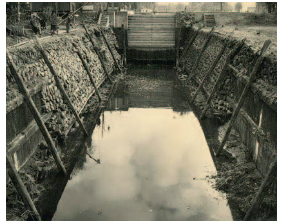
De Pothoofdsluis. Te zien zijn de bekleding met basaltblokken, de schotten en de trap opzij. (Foto CO)
