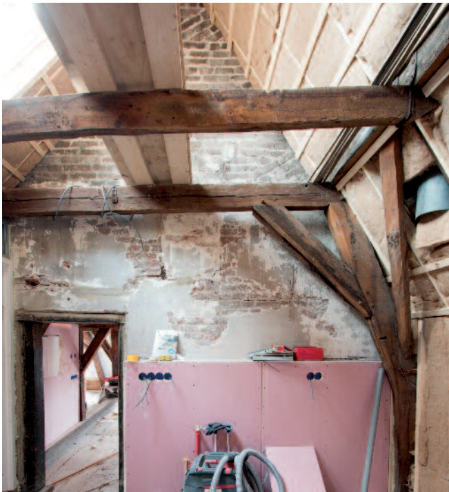
De oude topgevel die met de bouw van kap B inpandig is geraakt en zichtbaar in het zolderappartement rechtsachter van Brink 12. De foto is genomen vanaf de voorkant van het pand (Foto Geert Oldenmenger BAAC, 2022)
